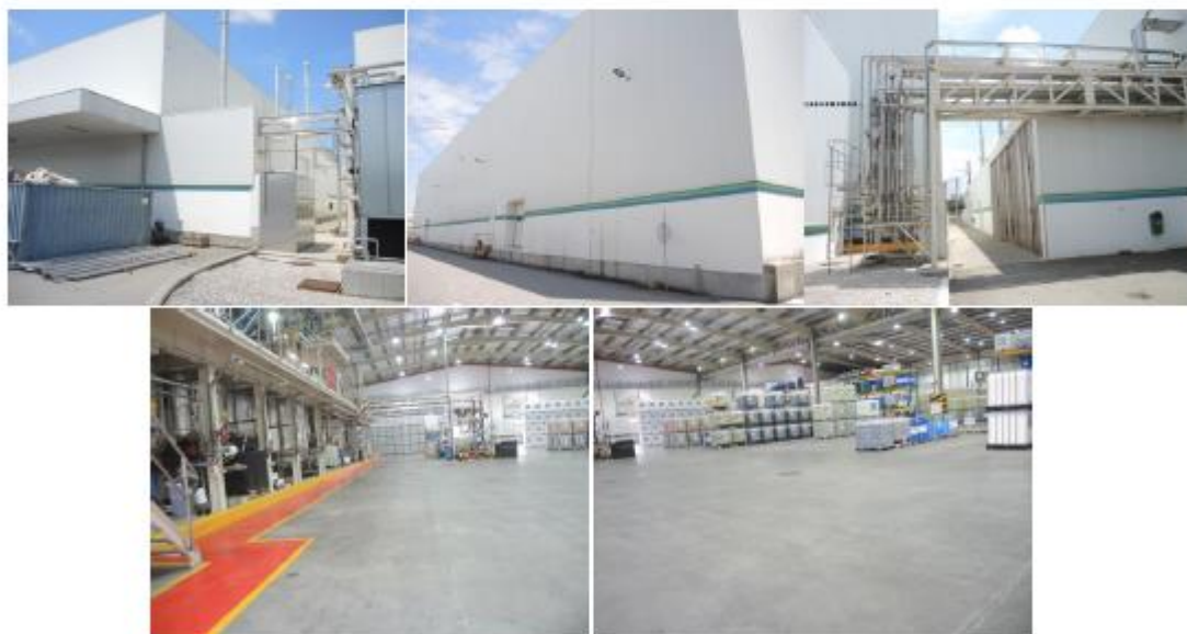
Foto 2, 3 e 4 – Várias vistas do exterior da unidade.
