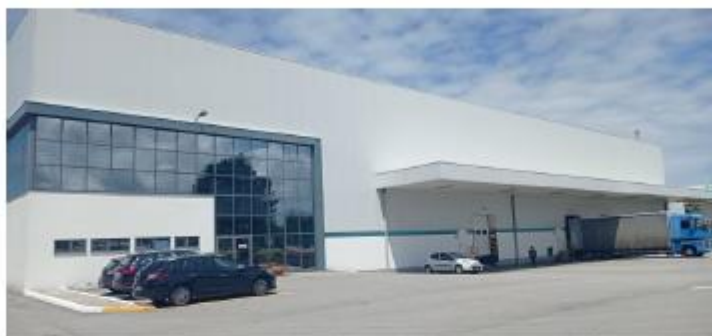
Foto 1 – Vista geral da fachada da unidade industrial.
