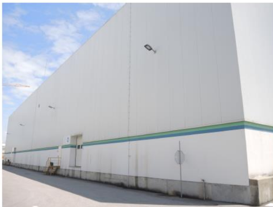
Fot.3 – Tardoz do edifício.
