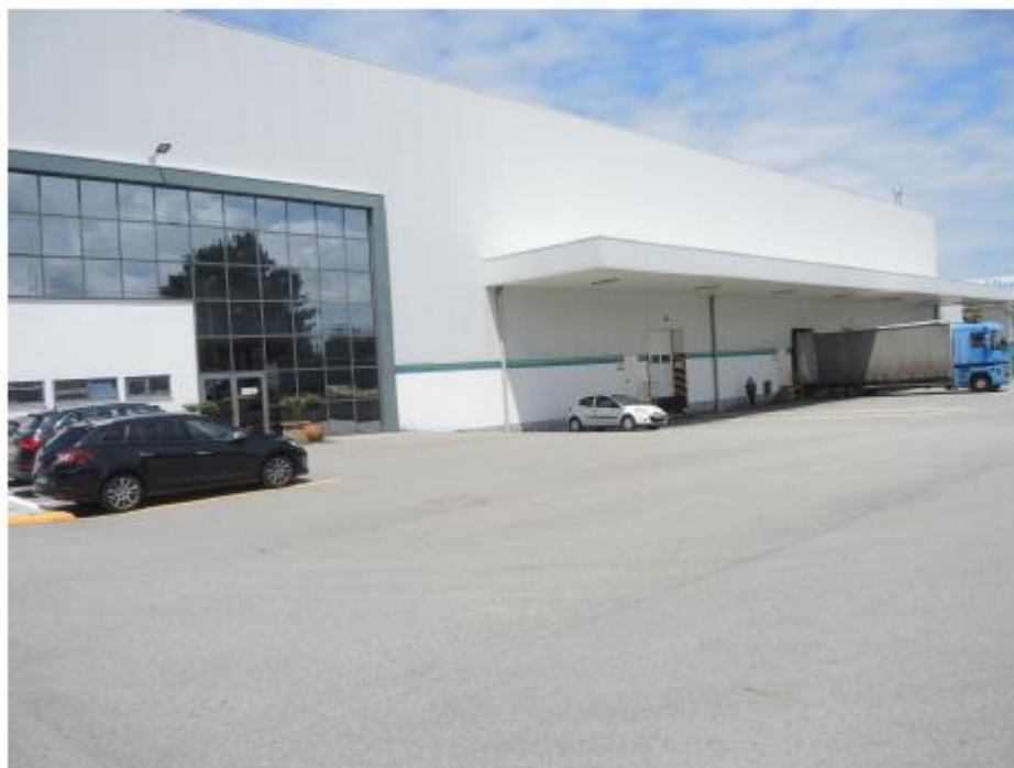
Fot.1 – Vista geral da fachada da unidade industrial.
